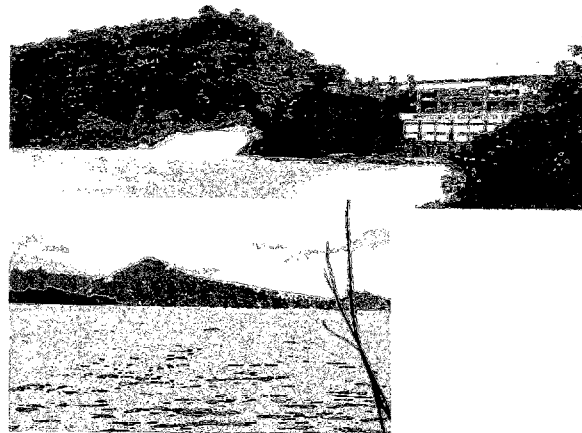
上：ダム堤体と発電施設 左：ダム湖面風景
