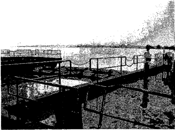
メコン川とチナイモ浄水場の取水口
