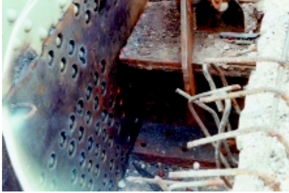
トラス格点部のカバープレートによる補修
