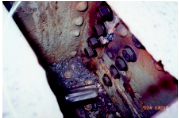
高力ボルト施工後の状況
