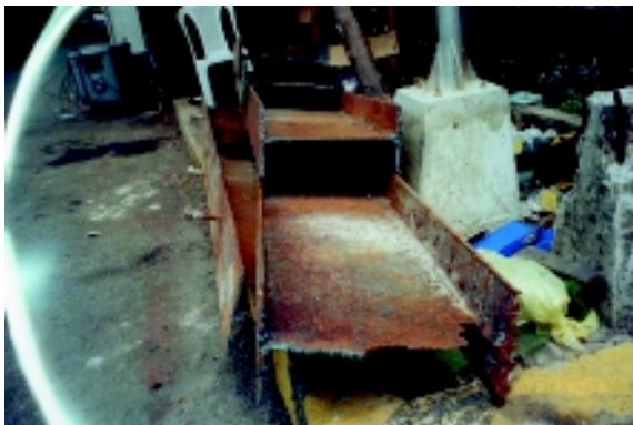
撤去された縦桁(腐食による減厚状況)
