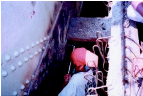
高力ボルト締め付け状況
