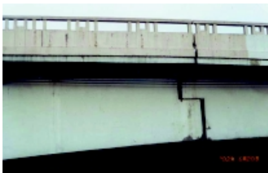
PC桁ゲルバー部の状況
