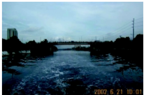
マカティ・マンダルヨン橋
