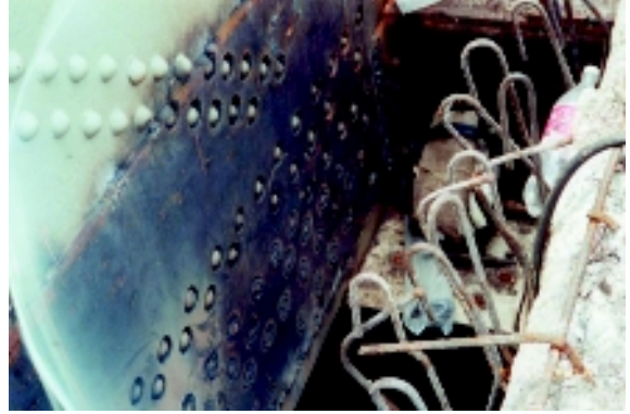
トラス格点部のカバープレートによる補修
