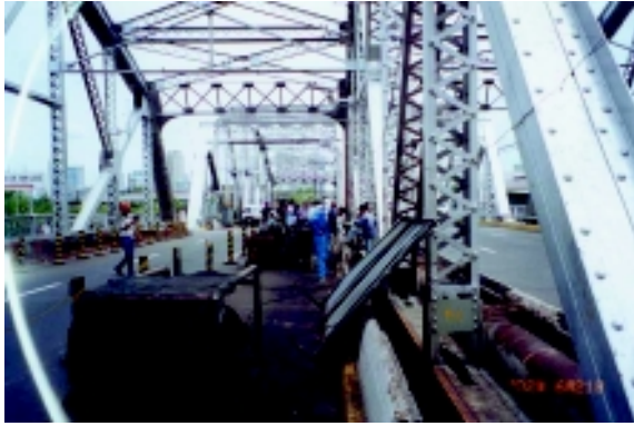
中分側の補修状況(車線規制)
