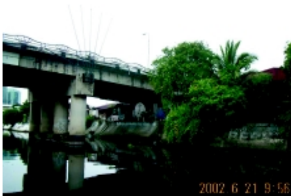
マカティ・マンダロン橋 橋台全面に十字架のある宗教施設あり
