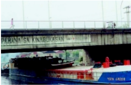
桁下クリアランスの状況
