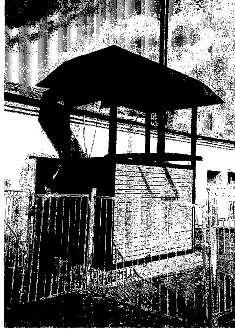
実験動物焼却炉全景
