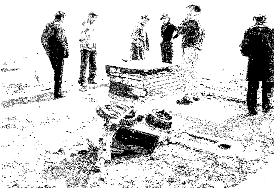
機械式井戸の跡地。ポンプ小屋やポンプは撤去され井戸を覆う箱がかぶせられている。旧ソ連が設置したポンプが放置されている（ドンドゴビ県）。
