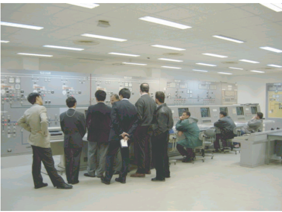
ジャンダール発電所中央制御室
