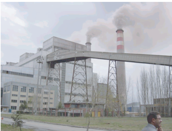
セイトメル発電所全景
