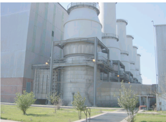
アンバリ発電所概観
