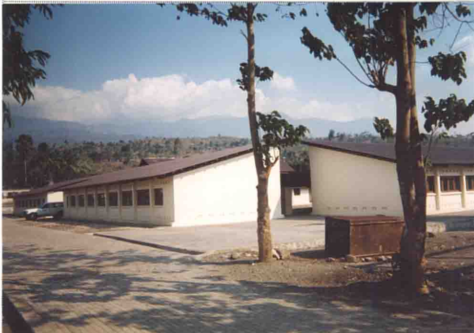
写真(11) SMP2 MALIANA(公立 中学校) マリアナにある当中学校 は、ESRPのPrototype School として新築され た。建物入り口からみた 全景。
