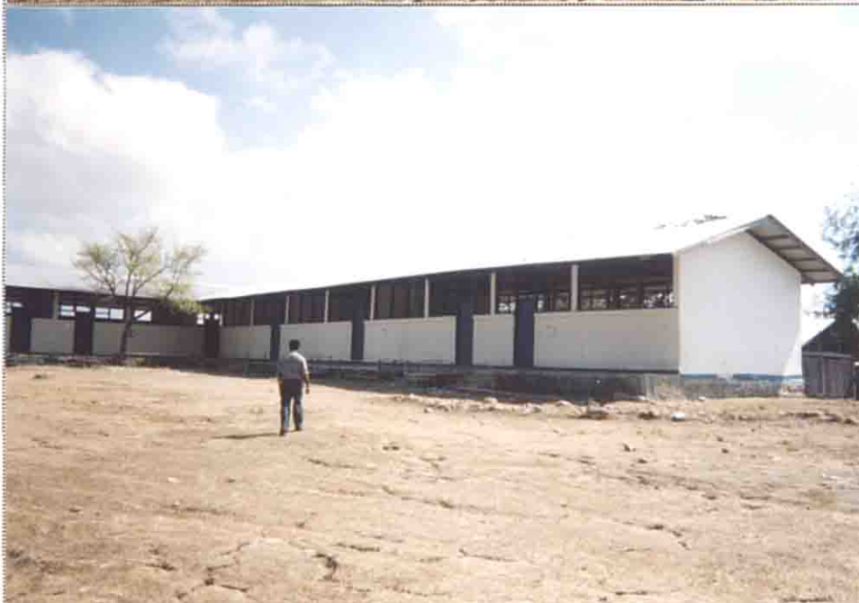
写真(6) SDK BALIBO(カトリック小学校) ESRPによって、改修された教室棟。屋根は、UNICEFが改修した。
