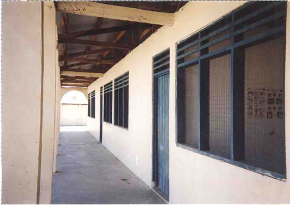
写真(4) BENUNUK Primary School(公立小学校) ESRPIによって、改修された教室棟。屋根は、破損が無い為手をつけていない。窓フレームやドアのペンキが剥がれ、ドアの開閉も良くない。
