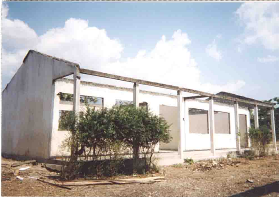
写真(2) SMP BEADILA(公立中 学校) 廃墟と化した教室棟。屋 根、壁が破壊されてい る。
