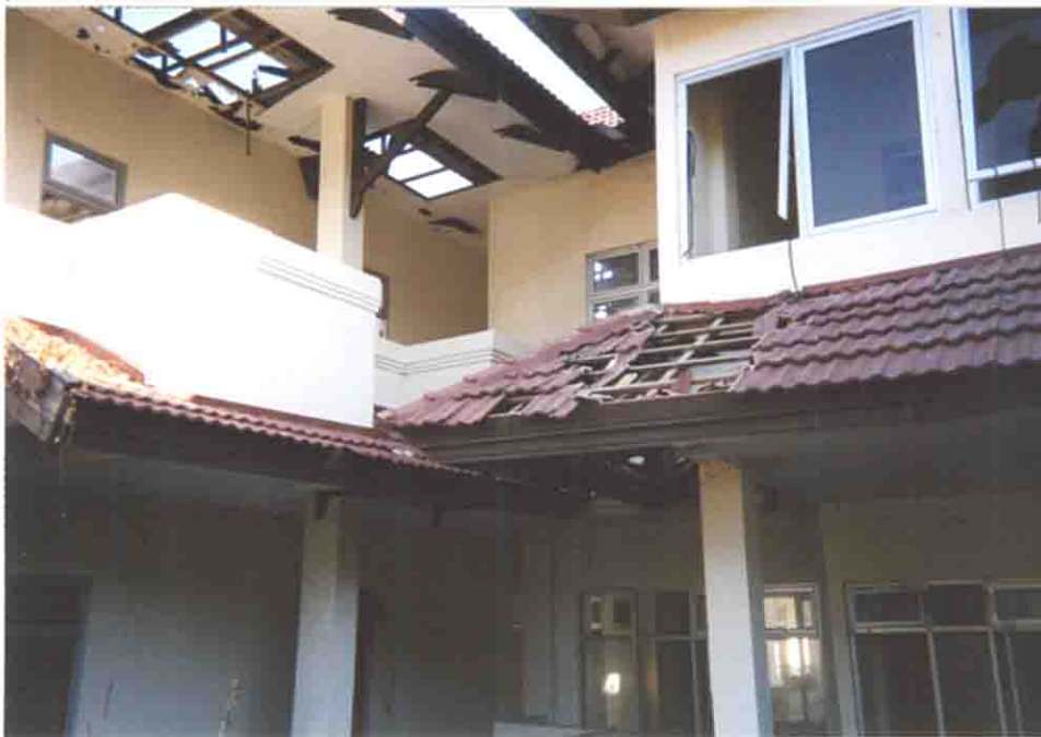
写真(26) 東チモール大学工学部 ヘラキャンパス 破壊された学生寮の外 観。
