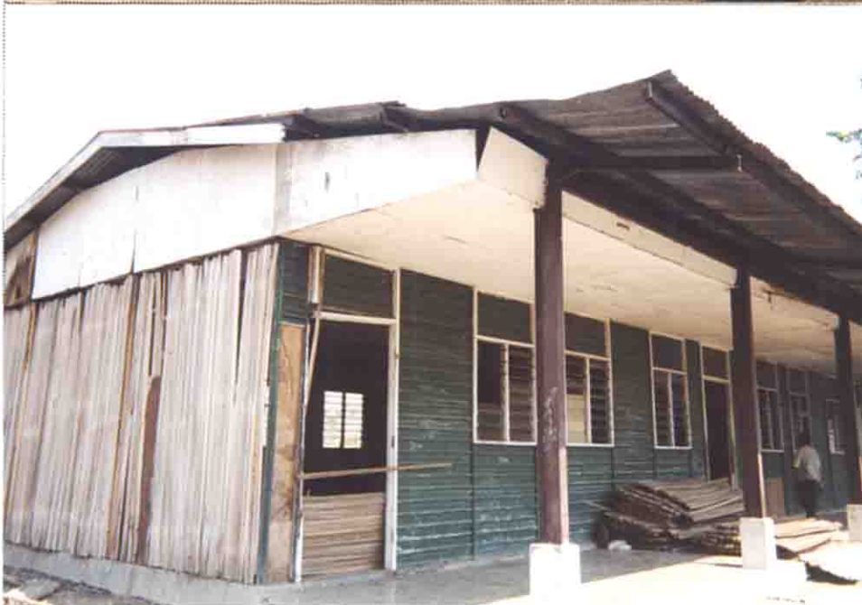
写真(3) SMP BEADILA(公立中 学校) 現在使用している教室。 老朽化し、また破損した 壁が応急処置されてい るが、学習環境の劣悪 な状態にある。
