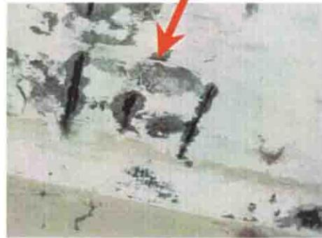
腐食した鉄筋。施工時鉄筋被りが不十分なため発生している。コンクリート内部の鉄筋にも腐食が連行されている恐れがある。
