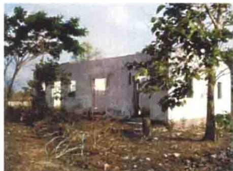
実験室。屋根、戸、窓枠が略奪されている。
