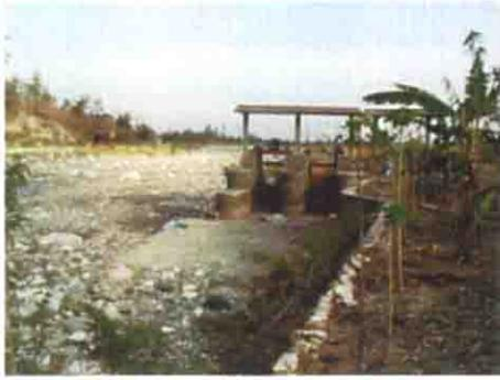
取水口。取水口前面の河床が低下して、取水できない状況になっている。
