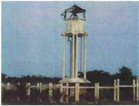
高架水槽(揚水した地下水を貯水し、各施設に排水する。揚水ポンプがない。)
