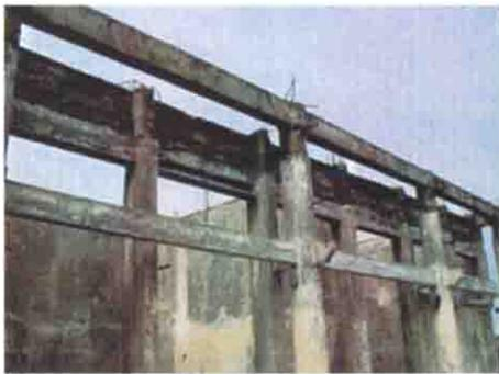
破壊時に残った柱、梁及び壁の一部
