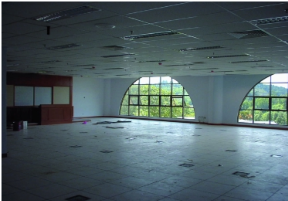
工事中のマレーシア・サテライトセンター予定場所
