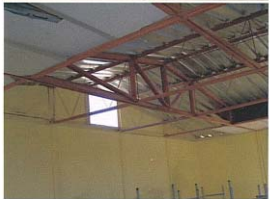
外壁パネルの脱落等、損傷が著しい。
