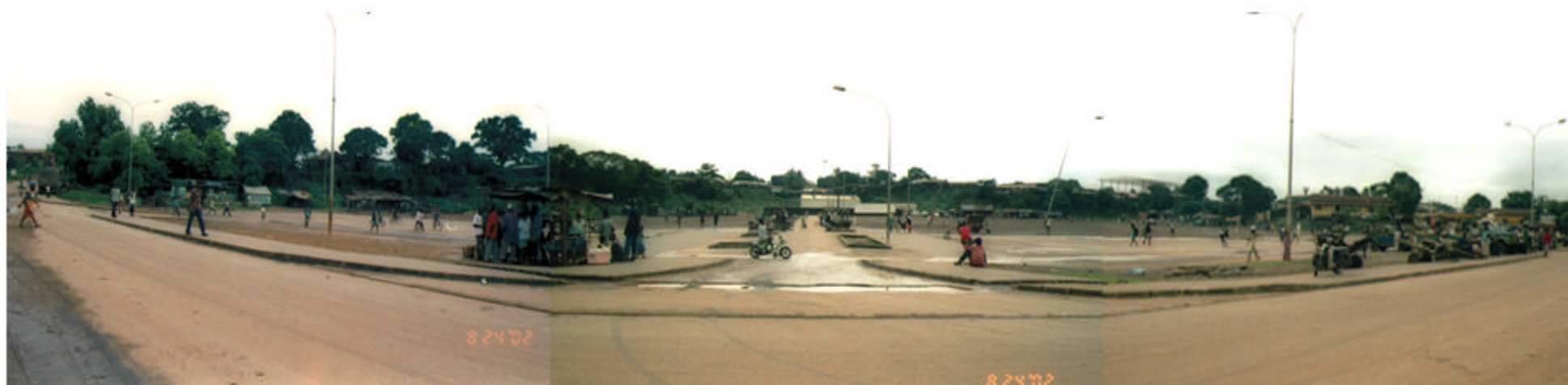
サイトの現状（２）：プロジェクト・サイトを西側公道から望む。左側部には手前から卸売市場、管理事務所、公衆トイレが、中央部に小売市場、右奥部には薫製魚倉庫が建設される。
