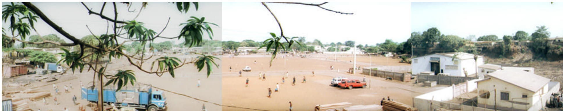
サイトの現状（１）：プロジェクト・サイトを東側から望む。左側部に薫製魚倉庫、中央部に小売市場、右側奥部に卸売市場、管理事務所、公衆トイレが建設される。右側部にある既存施設は手前から全国女性仲買人組合連合会、ケニアン製氷・冷蔵施設である。
