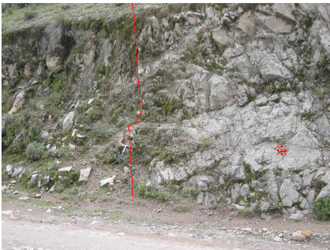
No.163 Afloramiento de brecha volcánica dacítica Superficie de intrusión: N25O, 85N Lado izquierdo: lutitas silicificadas (N15O, 65NE) Lado derecho: brecha volcánica (※: Muestra de roca 018HH)
