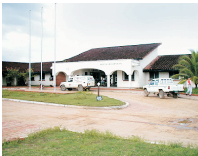
■ Trinidad: Hospital Materno Infantil En el 1982 esta facilidad medica fue construida por un préstamo de colaboración japonés. La facilidad es mantenida en muy buen estado, pero su equipo se ha convertido demasiado viejo.
