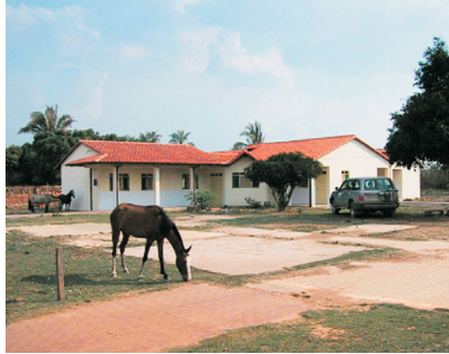
■ San Ramón: Ex CS-Hp / Edificio Nuevo Debido a la actividad el FPS recientemente ha construido un nuevo edificio pero no lo ha equipado.
