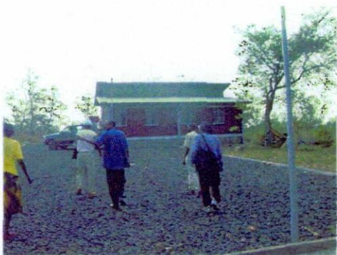
ガンベラ州 送信所建造施設入口
