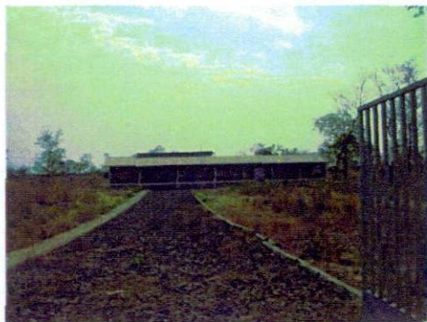
ガンベラ州 標準スタジオ建造施設入口
