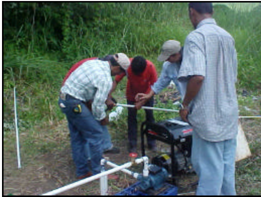
Fotografía 1. Preparación para el proceso de bombeo en el pozo #1.
