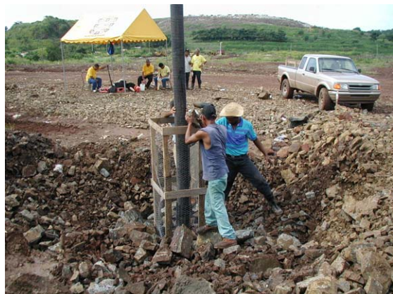
Colocación de una tubería para la evacuación de gases
