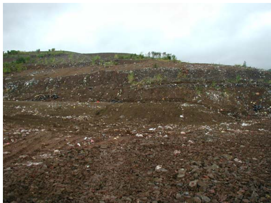
3) El desecho fue cubierto con suelo luego de su compactación con el fin de prevenir su esparcimiento y evitar malos olores
