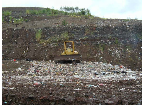
2) El equipo pesado compactó apropiadamente los desechos
