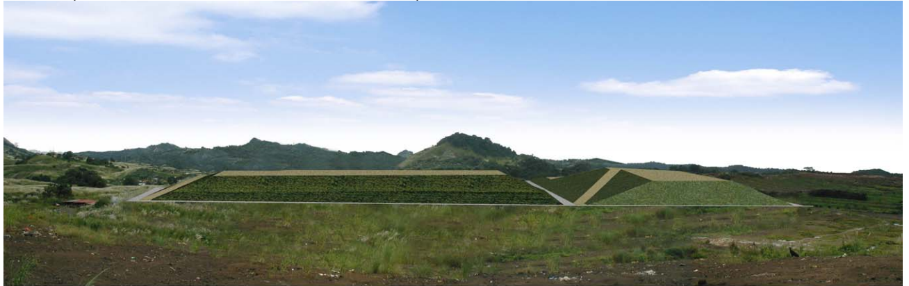
Fase 3 (antes de iniciar las tareas de relleno)
