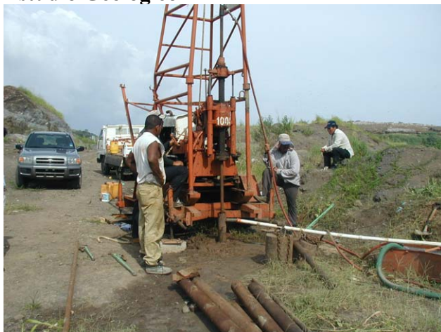
Perforaciones para el Estudio del Sub-suelo
