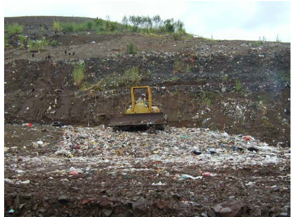
2) 重機を使用してごみを転圧
