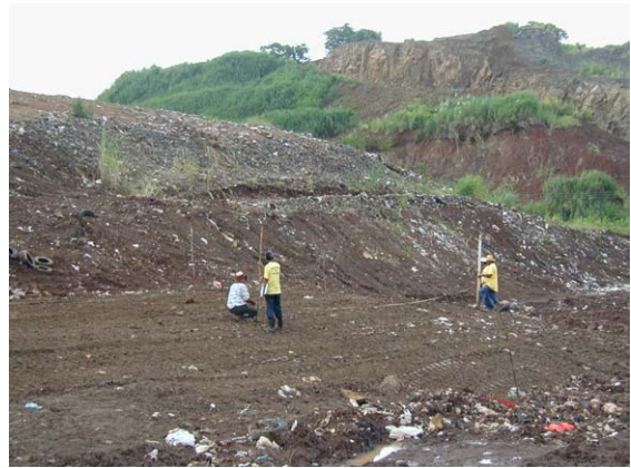
4) 作業終了後、モニタリングの一環として埋立エリアの計測
