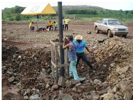
ガス抜き管の設置
