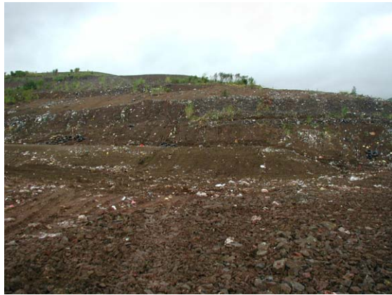
3) ごみの飛散及び悪臭防止のため覆土を施す
