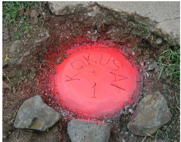
セロ・パタコーン処分場敷地内に仮基準点を設置
