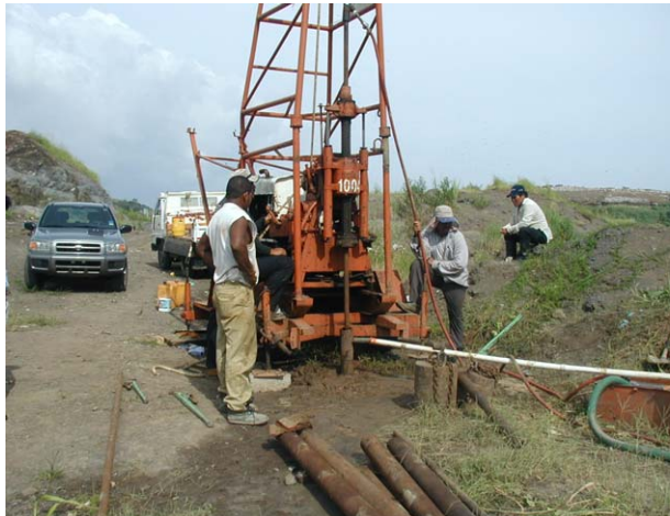
ボーリング調査
