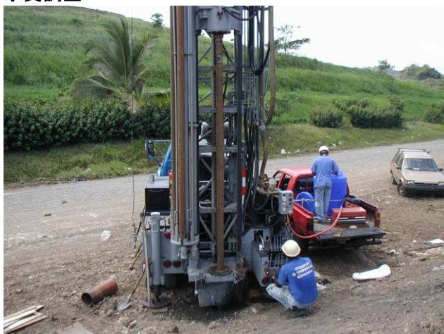
地下水採取のために井戸を掘削
