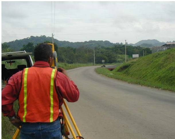
トータルステーションを用いて測量調査
