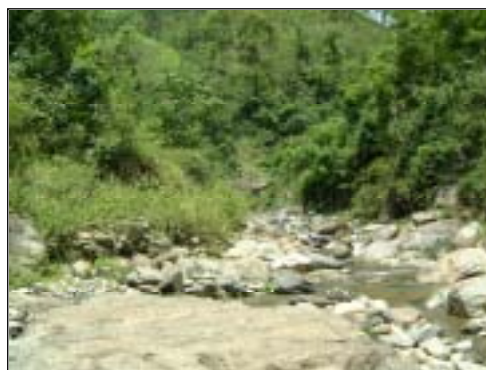
ヤンラン川下流砂防ダムサイト
