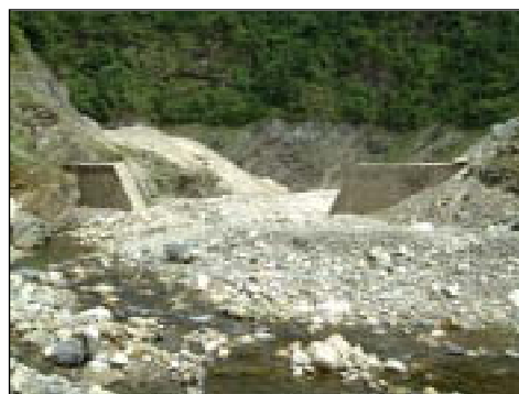
ダルクット川 D1 砂防ダム堆砂状況
