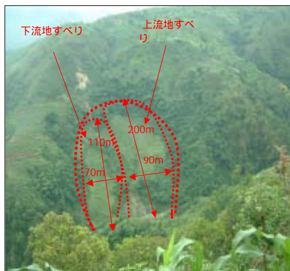
調整池右岸の地すべり地形
