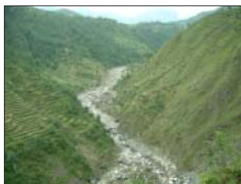
砂防ダム No.1 上流堆砂状況
