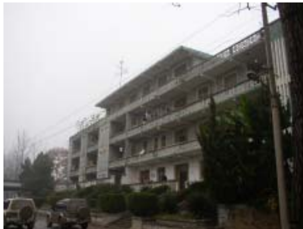
No.32 華陽河 屋上に太陽光パネルと雨量計設置 3階観測室に観測テレメータシステム設置を計画
