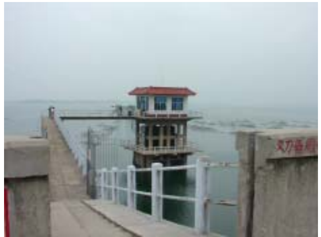
No.6 鴨河口ダム 水位テレメータシステム機材設置予定場所 (灌漑用ダムゲート操作室)
