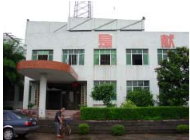
⑨杜家台ゲート管理所（N59）水位計3台設置予定
