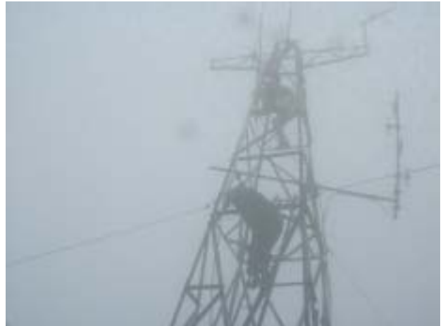
大洪山中継局 VHF 電波試験
