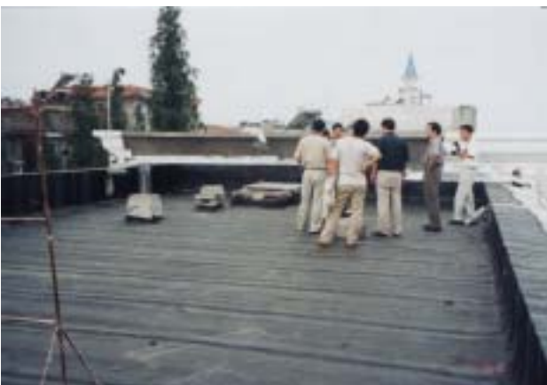
屋上には VSAT アンテナを設置予定 (各集合同局共通)
