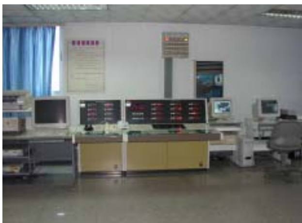
コントロールセンター
