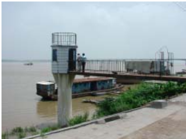
No.48 宜城 データの送信は、観測位置から200m離れた観測所までVHFを採用し、観測所からはインマルサットCを採用する
