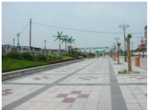
整備された漢江の堤防周辺 (襄陽水文所前)
