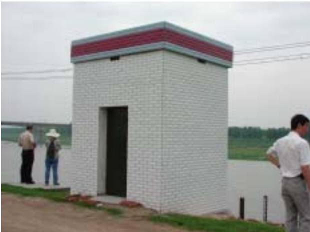
No.57 岳口 小屋上に太陽光パネルと雨量計設置 バブル式水位観測テレメータシステム設置を計画
