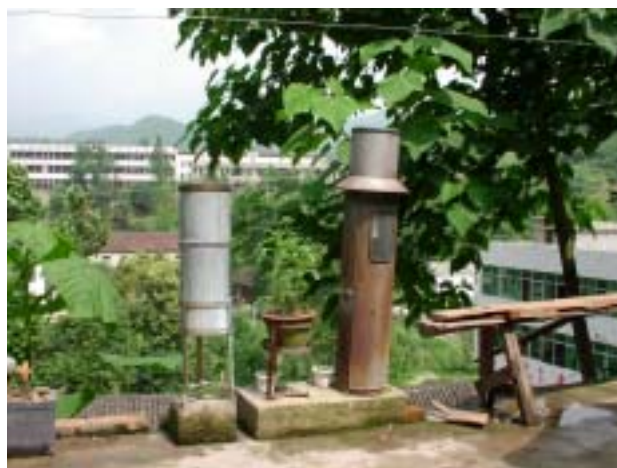
No.45 李廟（非公開地域） 既設の雨量計 太陽光パネルは手前平屋屋上に設置を計画 雨量観測テレメータシステム設置を計画
