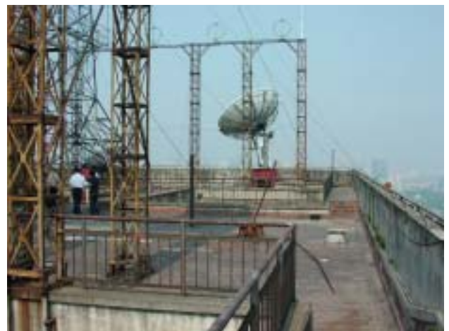
長江水利委員会本館屋上 VSAT 及び Inmarsat アンテナ設置予定場所
