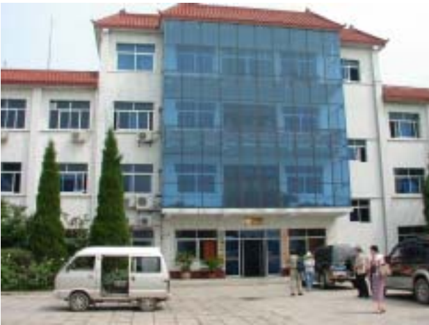
鴨河口ダム管理所 (③集合局) データ収集・処理機材設置予定場所
