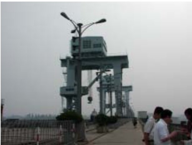
丹江ロダム ゲート用クレーン
