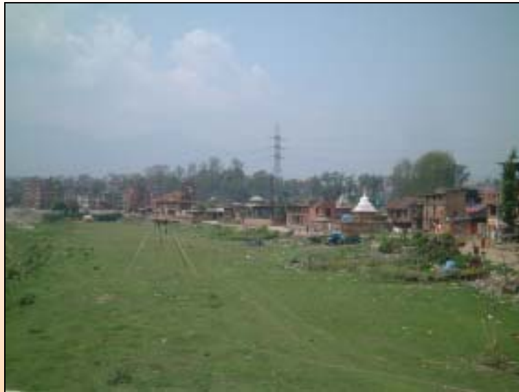
Teku 変電所～Siuchatar 変電所間を結ぶ 66kV 送電線
