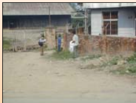
Teku 変電所前
