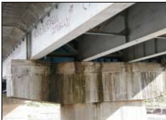
P1橋脚の嵩上げ状況
