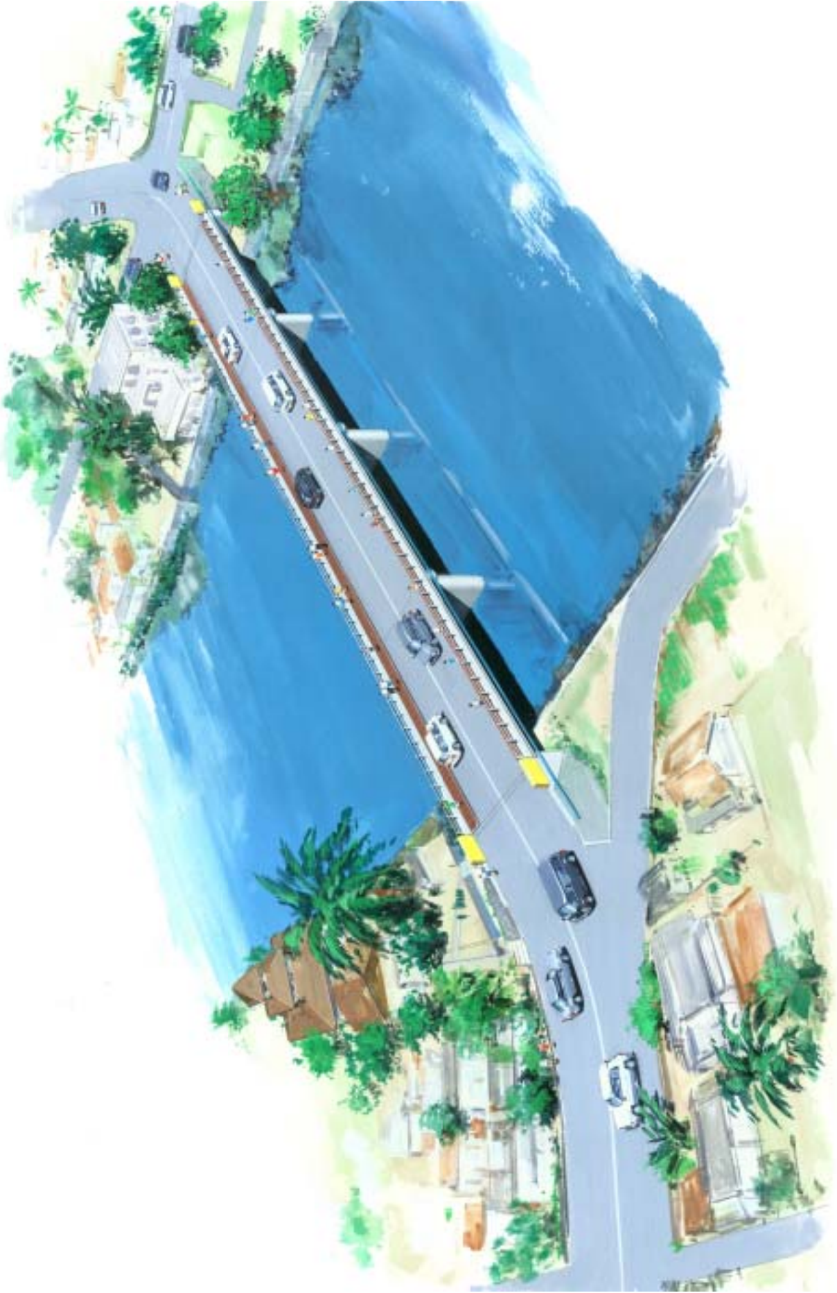
完成予想図 - 3 北スラウェシ州：施設建設型 (ポストデモン ホロースラブ橋：メガワTEE橋)
