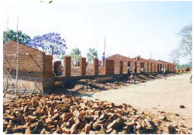
Photo 8-8 MASAF 基金により建設中の校舎 (Nambuma TC in Dowa District)
