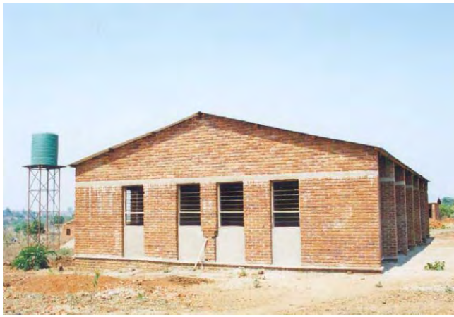
Photo 8-7 MASAF 基金により建設された校舎 (Kwitanda TC in Balaka District)
