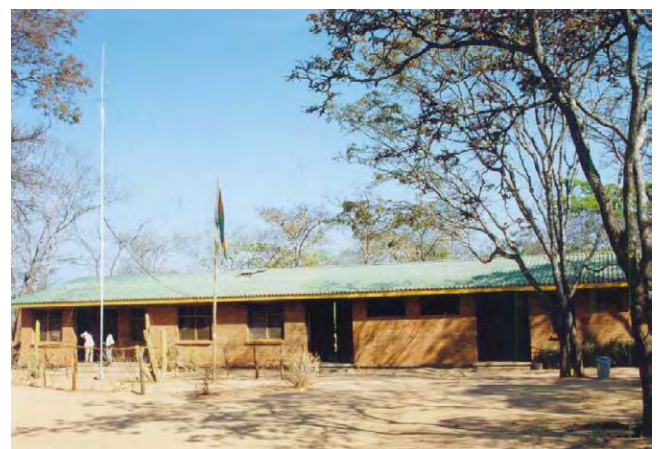
Photo 8-6 SHS による電化済み病院 (Mbalachanda TC in Mzimba District)
