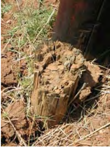
図 5-1-6 立て替えられた電柱
