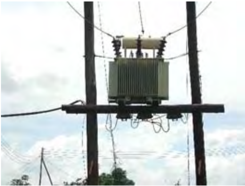
図 5-1-8 変圧器(100kVA)
