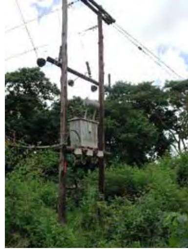
図 5-1-7 変圧器(50kVA)
