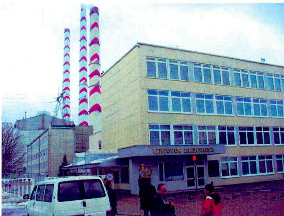
エレクトレイナ（リトアニア）火力発電所
