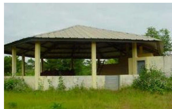
Daoukro小学校の給食室 教育省の標準設計によるもので屋根は木造トラス構造。
