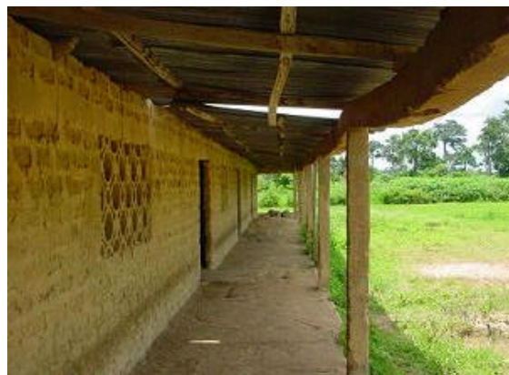
YM-02 Affere-2小学校 住民によって建設された日干し煉瓦造の校舎。
