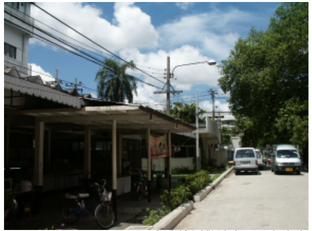
事務棟側敷地内の既存食堂
