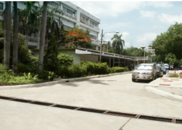
事務棟側敷地全景(奥は隣地の建物)
