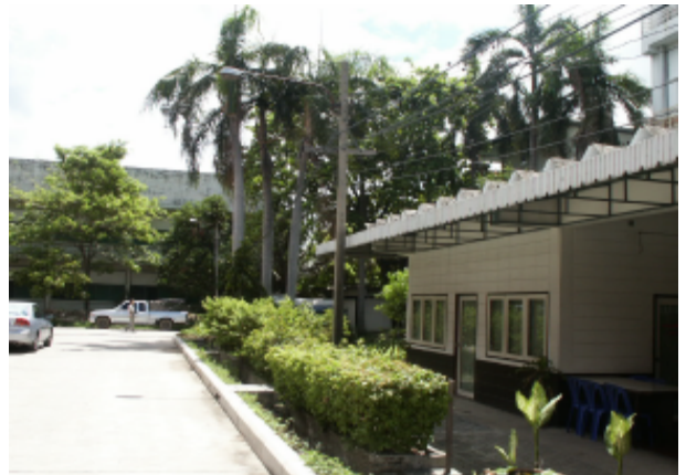
事務棟側敷地内の既存食堂(空調室)
