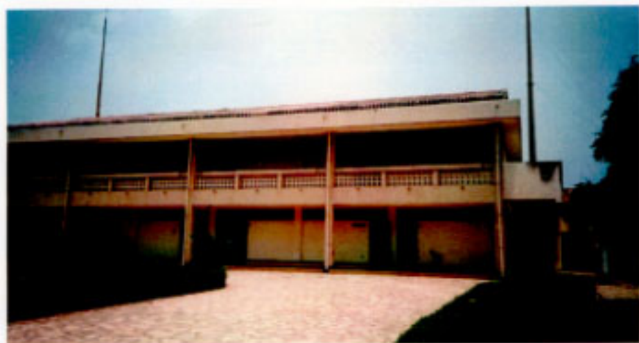
電子実習棟 北側
