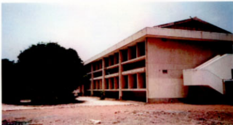
管理棟 北西コーナー
