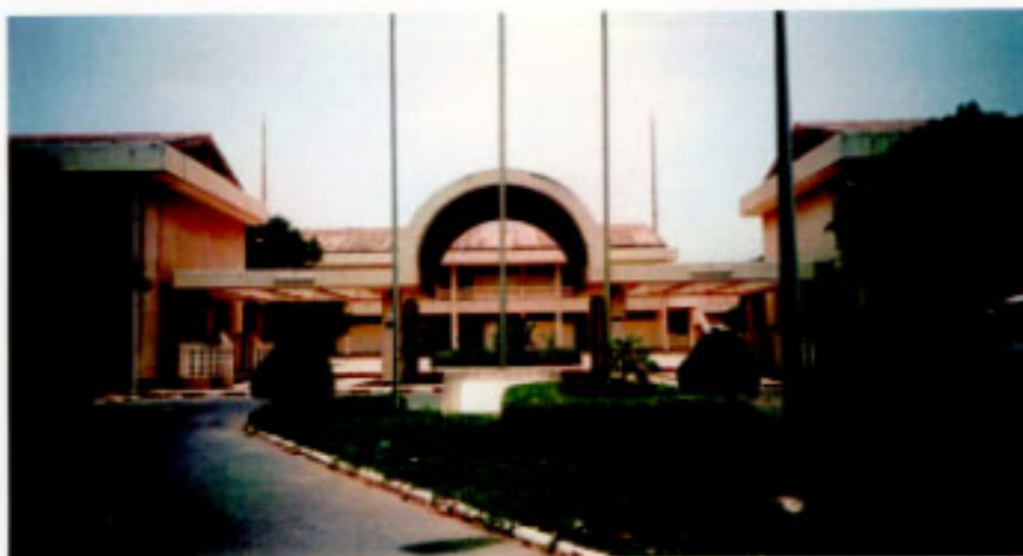
正面アプローチ、銘板（左:教室棟 右:管理棟）
