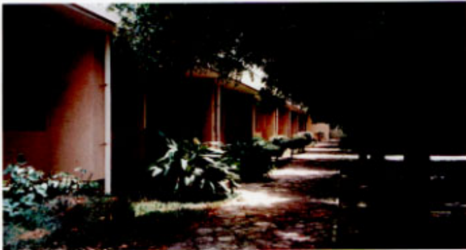
機械実習棟 北側（電子実習棟との中庭）
