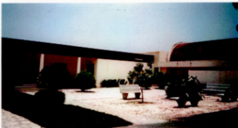
既存BTS棟 正面(西側)（右:便所棟）
