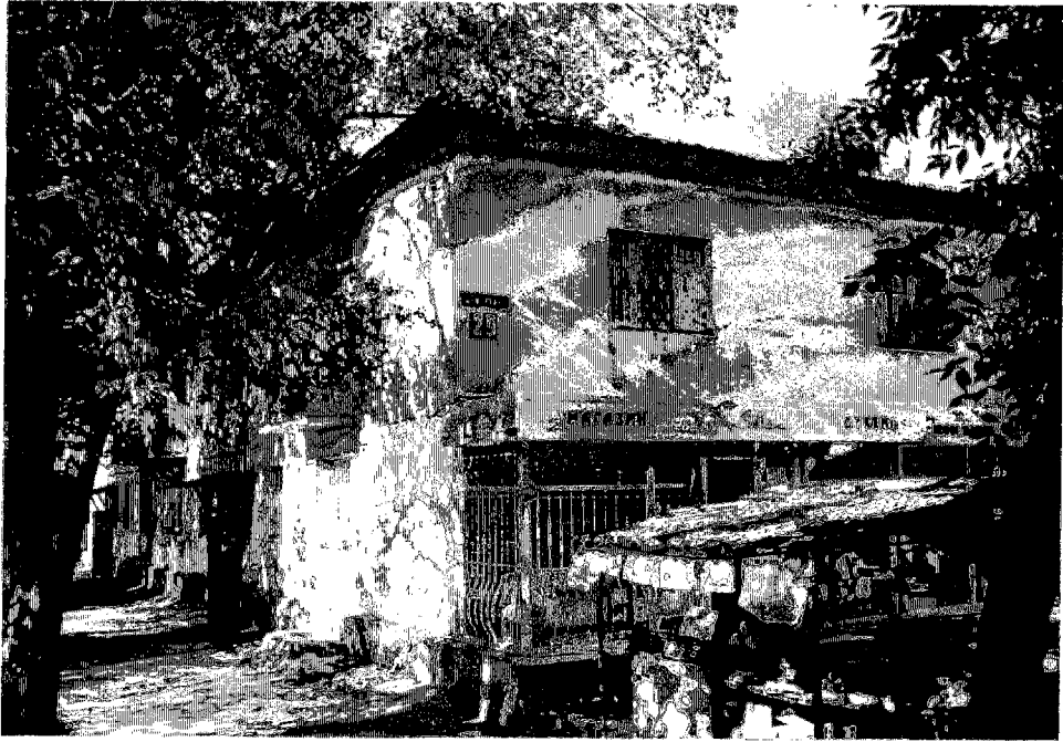
▲この建物の地下に強震観測機器が設置されている。
