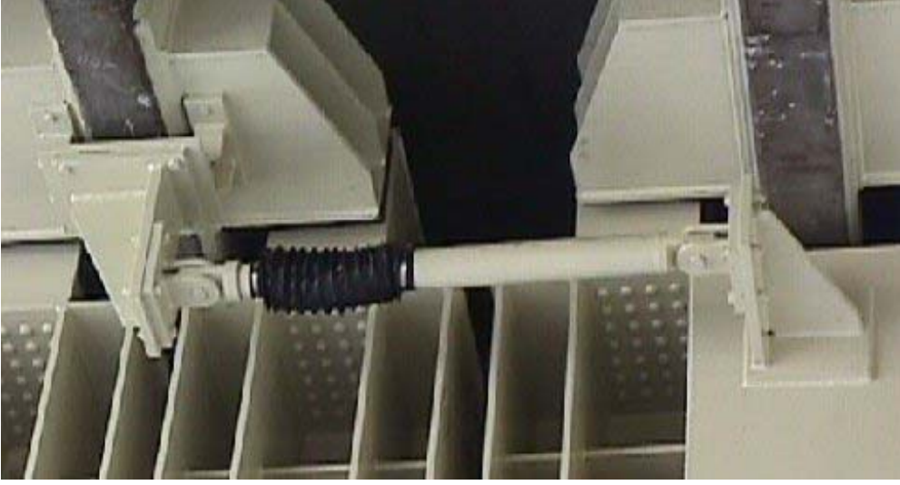
Şekil 9.5.6 Damper ile deplasman kontrolüne bir örnek
