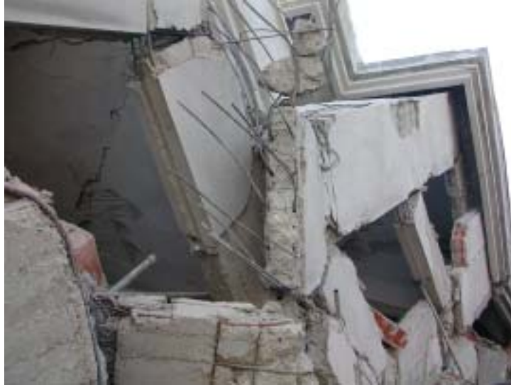
Foto. 9.1.3 Kolon ve kiriş arasındaki tahribata bir örnek
