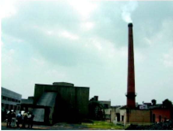
貴州アルミニウム公司ボイラー建屋、 脱硫装置、煙突
