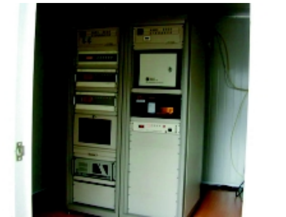
自動モニタリング装置(左上)大気質自動測定器、(左下)データ伝送部、(右)気象測定器
