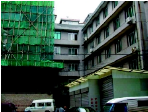
貴陽市環境保護局自動大気監視局局舎 (正面屋上)
