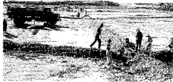
デモンストレーション埋立地建設状況 (面積2ha)
