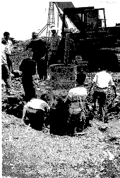
廃ドラム缶や竹を活用したガス放出設備の設置
