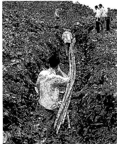
竹製の集ガス管の敷設
