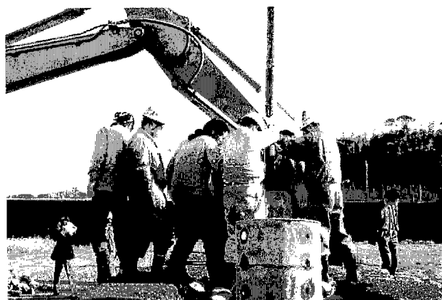
実技研修（竹やドラム缶を使ったガス抜き設備）
