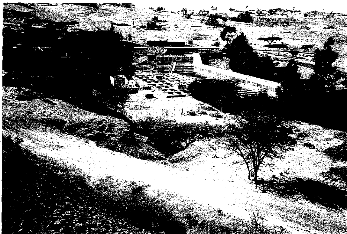
レガダディ浄水場 全景
