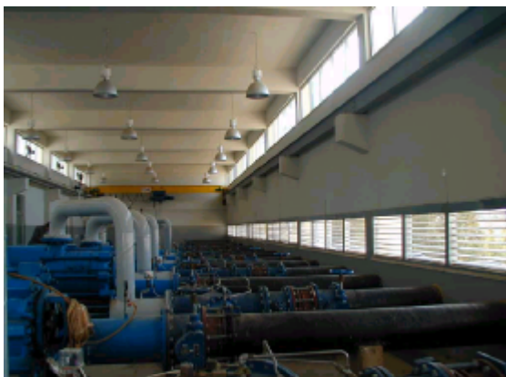
ハウポンプ場
