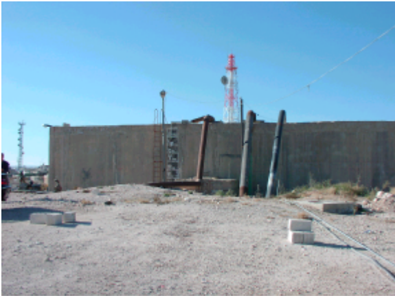
アワジャン高配水池(既存)
