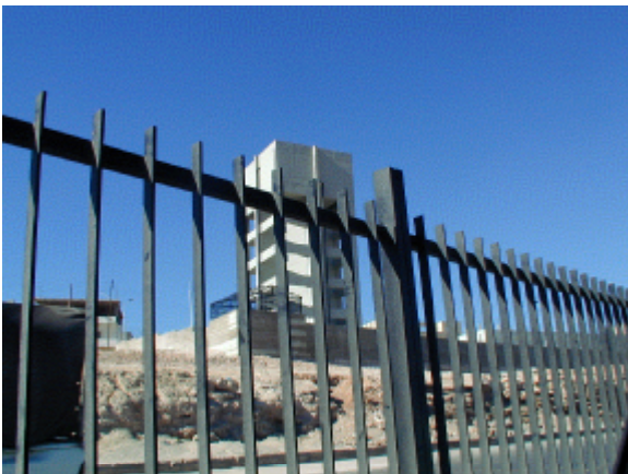
ハッテン配水池と高架水槽(既存)
