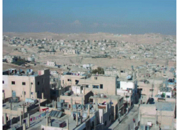
アワジャン高配水池(既設)よりルセイファ方向を望む
