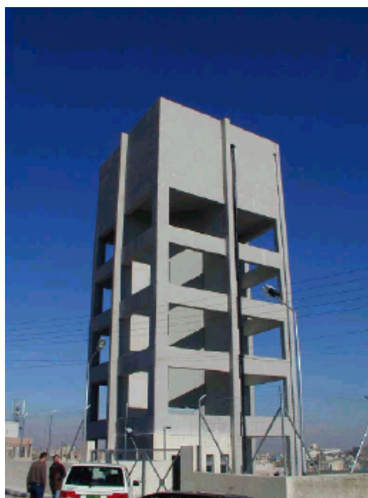
ハッテン高架水槽
