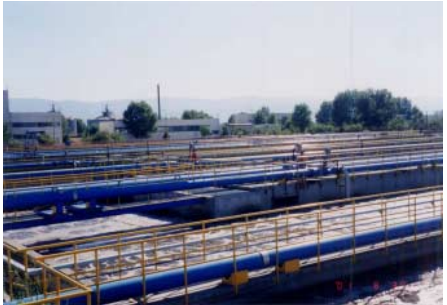
16 . プロヴディフ廃水処理場 の様子
