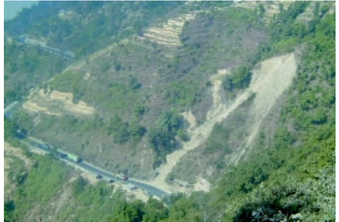
多くの箇所で地すべりが発生している
