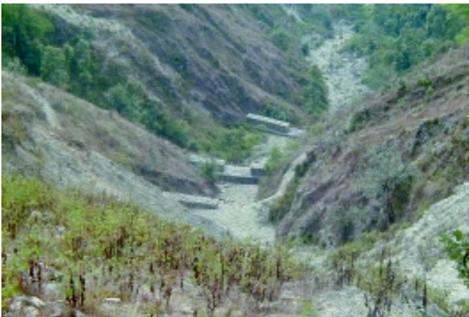
モデル事業として整備した砂防ダム
