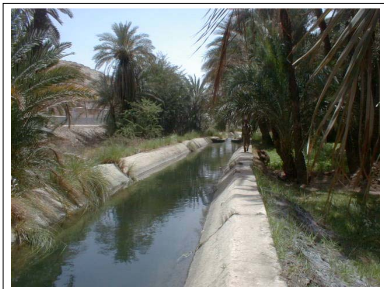
No.22 Sahel Alakaba Kebli ポンプ場の吐出水槽から続 く幹線水路：上流部はコン クリートでライニングされ ている。
