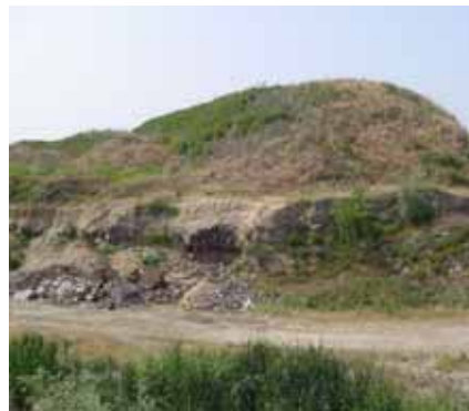
オープンダンピングされ、閉鎖された処分場跡（ブルガリア）
