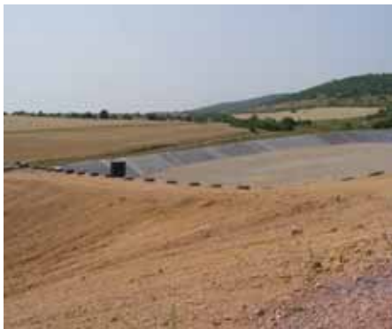
ライニングされた第1区画（ゴルナ・マリナ処分場
