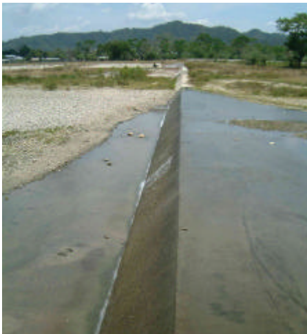
Presa de Consolidación
