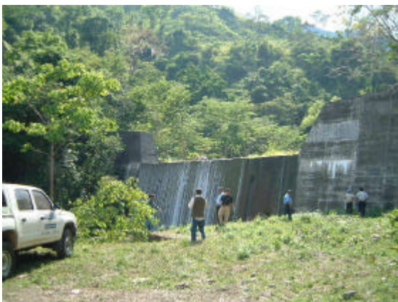
Presa para protección de sedimento
