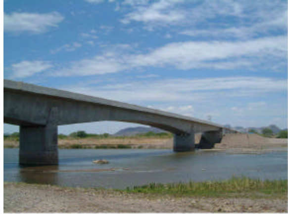
新 Cholteca 橋（Nuevo Puente de Cholteca）全景 （取付け道路は復旧事業によるもの）
