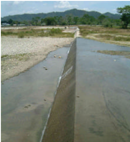
本事業による床固工
