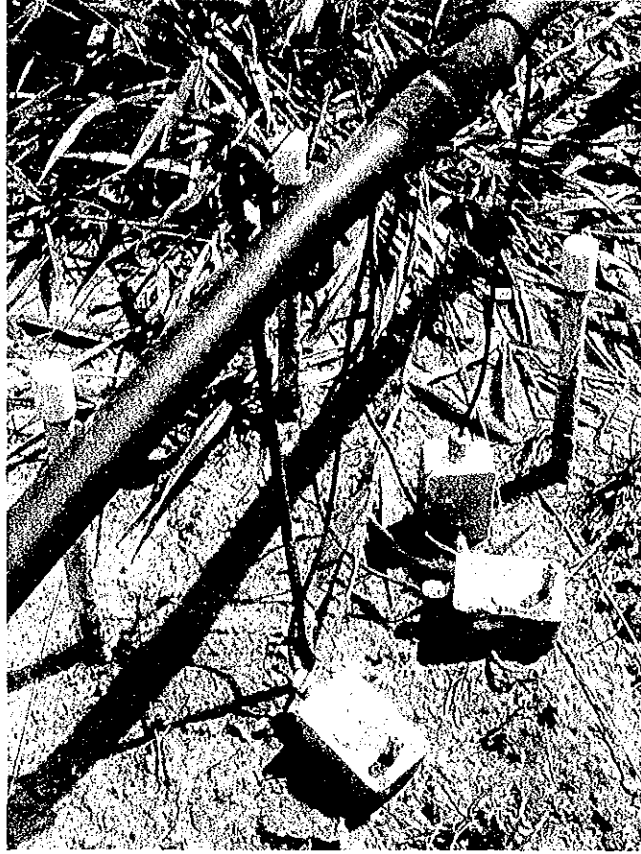
写真-19 土壤水分計の破損状況（センサーの接合部分が劣化している）
