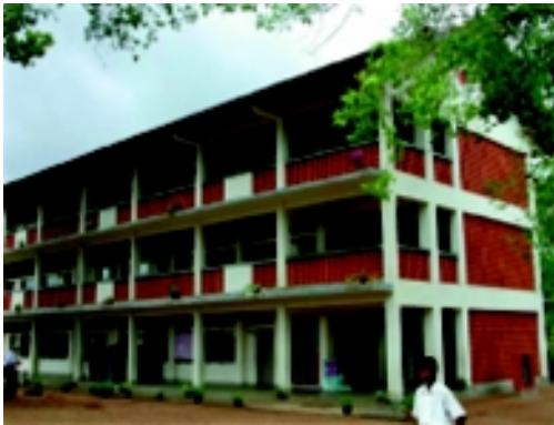
無償資金協力により建設された学校 ( Galpaya School )
