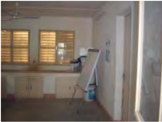
実験研究室内部
