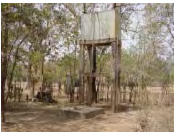
管理苗畑内既存井戸施設
