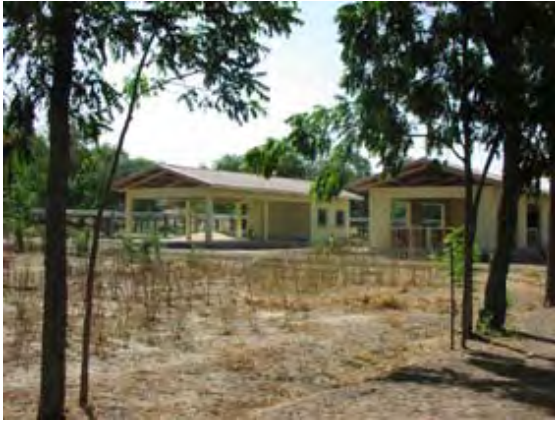
「地方苗畑改修計画」で建設された施設
