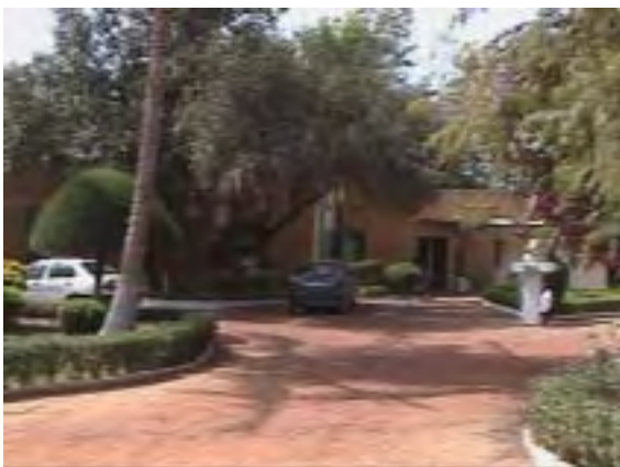
CNSF 本部事務所の外観
