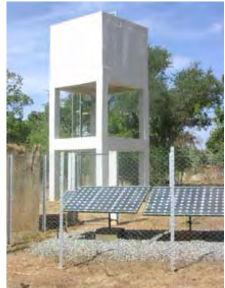
「地方苗畑改修計画」で建設された 太陽光発電による灌漑施設
