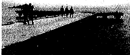
Jetty yang ada saat ini (Lokasi Soro) akan diperpanjang & ruang pelelangan akan dibangun pada ujung perpanjangan. Kedalaman air untuk 24-jam tambatan kapal akan terjamin.
