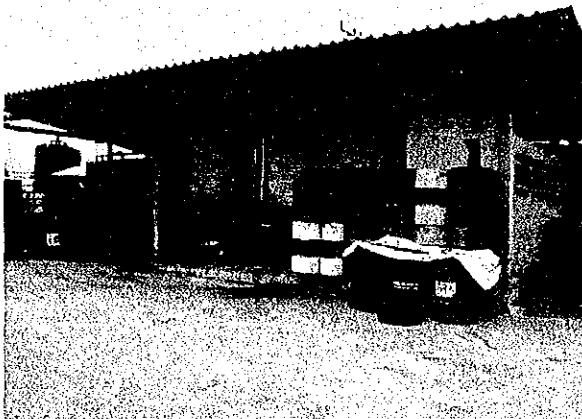
โรงงานรีไซเคิลน้ำมันเครื่องใช้แล้ว (1: ที่รับน้ำมันเครื่อง)
