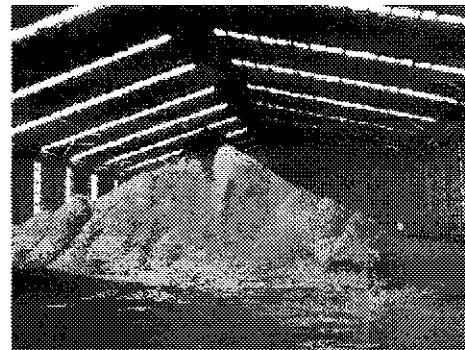
スラッジ貯蔵施設
