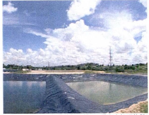
民間非有害廃棄物最終処分場(2:浸出水処理施設)
