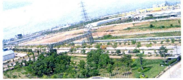
廃棄物処理工場:GENCO Map Ta Phut(2:建設中の新規処分場)
