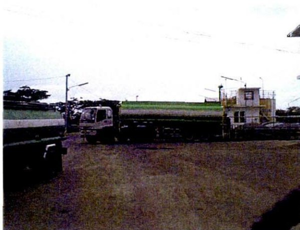
廃棄物処理工場: Genco Samaedumプラント (1: 排水受け入れ)
