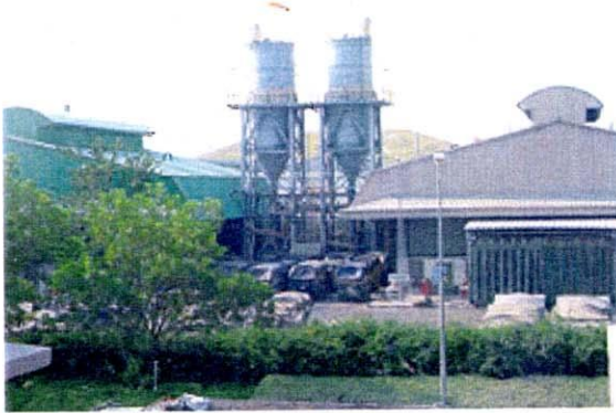
廃棄物処理工場:GENCO Map Ta Phut(1:汚泥安定化施設)
