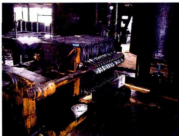
廃油リサイクル(3:再生油回収工程)
